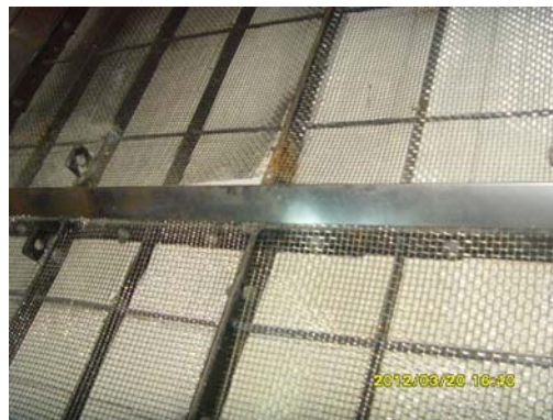
图 2 密封片焊点较少
