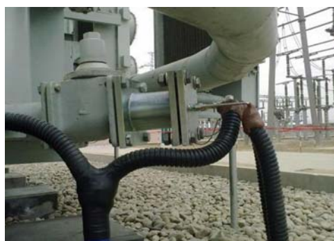
图5 放油阀传感器现场安装图
