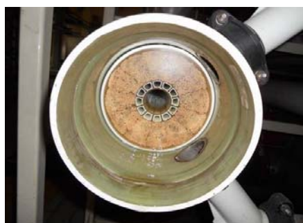
图4 超滤膜端口清洗后情况
