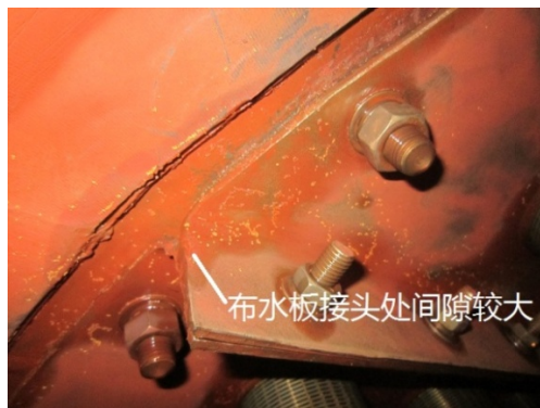
图9 布水多孔板接头处增加挡水装置前示意图
