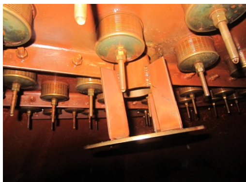
图4 高速混床内树脂管处布水多孔板下垂变形
