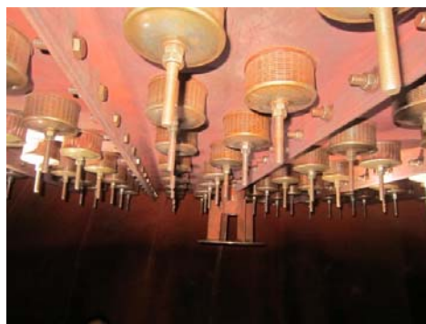
图7 高速混床布水多孔板平整后整体效果图
