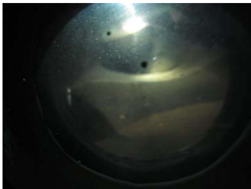
图3 树脂在高速混床中正常运行图
