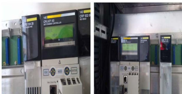
图 1 PLC 故障时主备 CPU 状态
