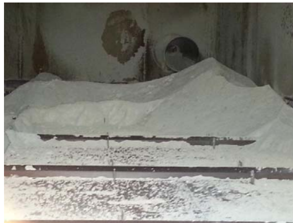
图 6 声波吹灰器出口处积灰严重
