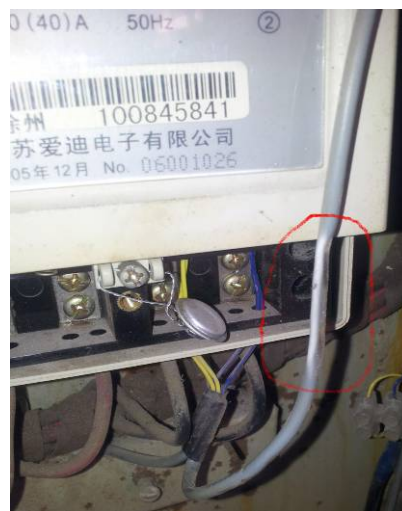
图 3 485 线被压在电表后变形造成内部短路
