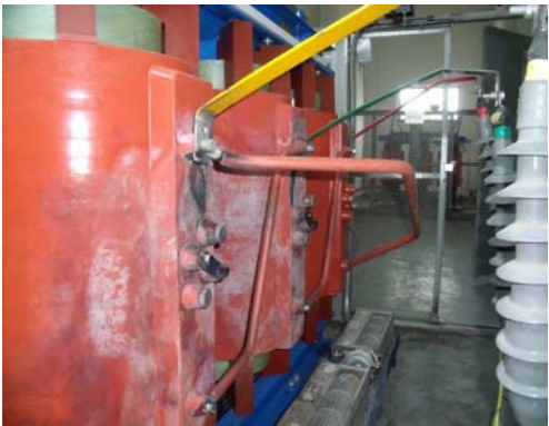
图 3 弧光烧蚀痕迹
