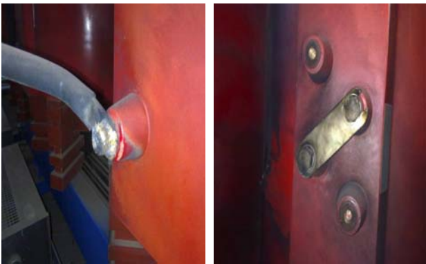
图 2 接头和分接开关图
