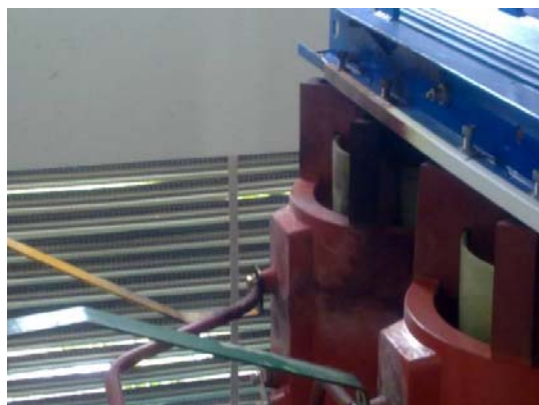
图 6 2 号所用变表面烧蚀情况
