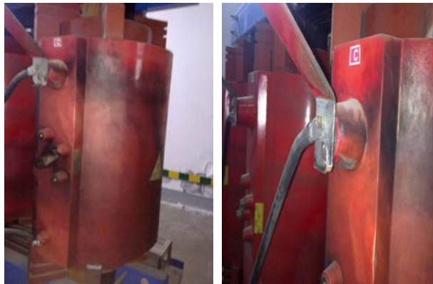
图 1 #2 所用变故障图片
