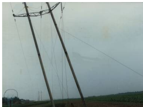
图 5 拉线被盗后倾斜的杆塔
