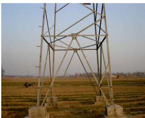
图 1 铁塔材料被盗
