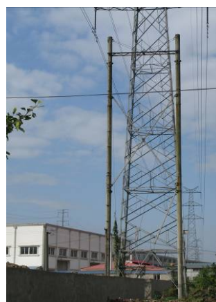
图 4 拉线被盗后的杆塔
