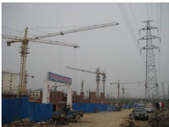
图1 施工塔吊和高压线路之间的矛盾
