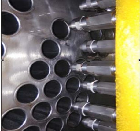
图 6 凝汽器进水室在线冲洗后
