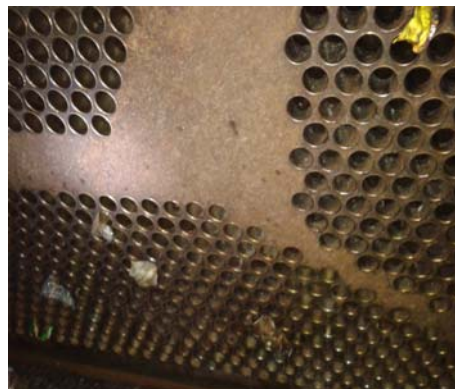
图 1 凝汽器进水室生物粘泥和杂物
