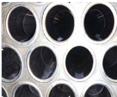
图 7 凝汽器出水室在线冲洗后
