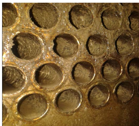
图 2 凝汽器出水室较厚的泥垢
