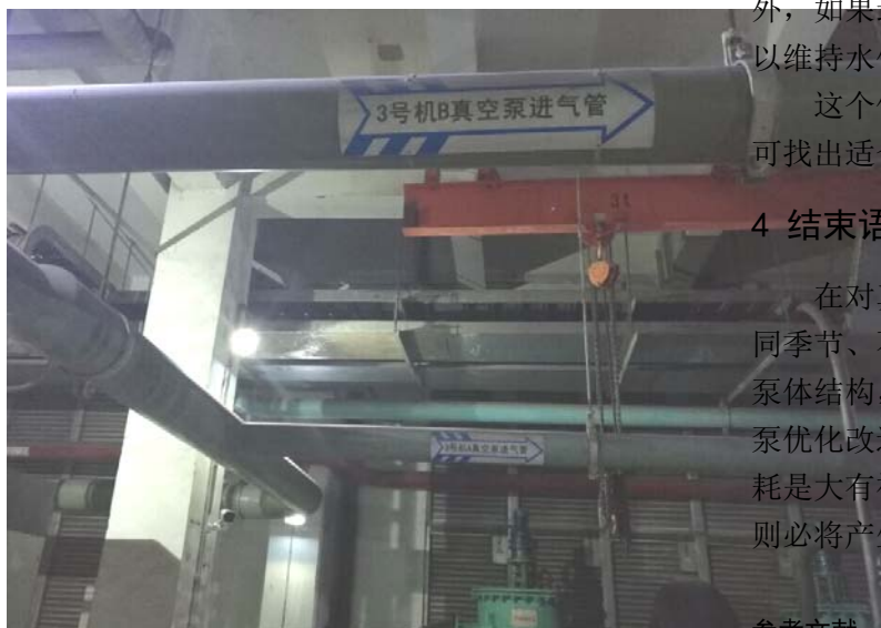
图 7 凝汽器至真空泵的进气管道
