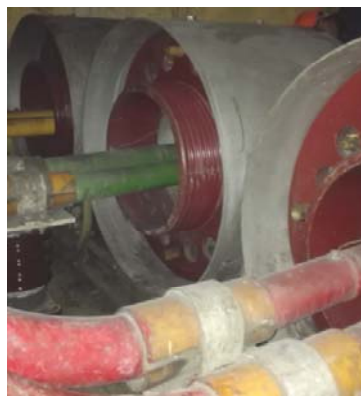
图 1 谏壁电厂 9#机组中性点引出方式
