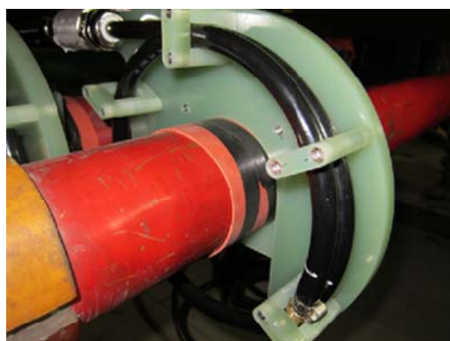
图 4 谏壁电厂柔性光学电流互感器现场安装方案 谏壁电厂 9 号机组中性点分支导体为圆管形导
