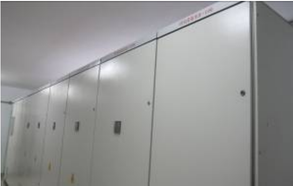
图2 5号发电机励磁系统屏柜布置图
