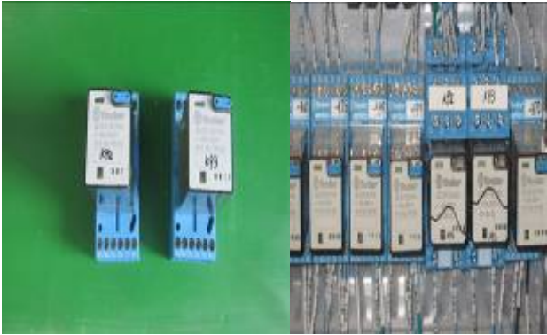
图5 5号机励磁系统大功率继电器K92、K93技改前后图
