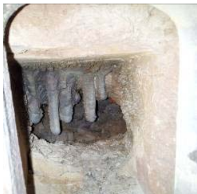
图 3 #1 炉 EF 层#1 角结焦情况
