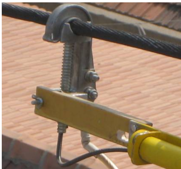
图 12 新型接地线完成装设
