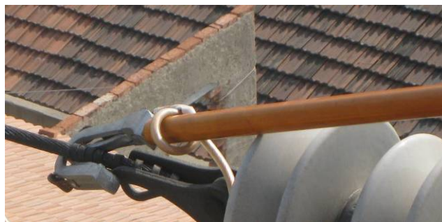
图 2 旧接地线装设情况
