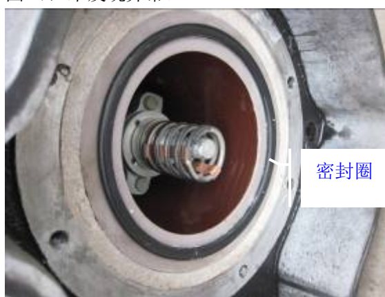
图 2 B 相上节避雷器顶部密封圈完好
