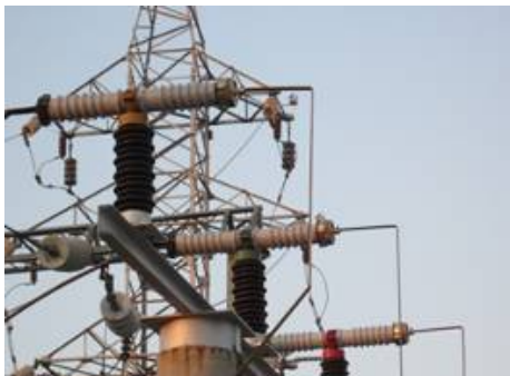
图 11 改进高压熔断器成功投入运行
