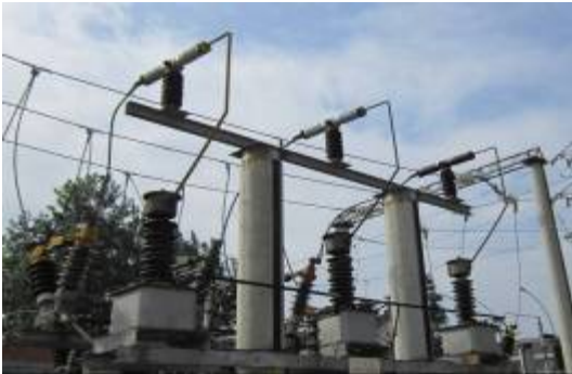
图 1 正常工作中的传统方式高压熔断器
