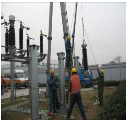
图 9 220kV 典巷变 110kV 竹舍间隔避雷器吊装现场
