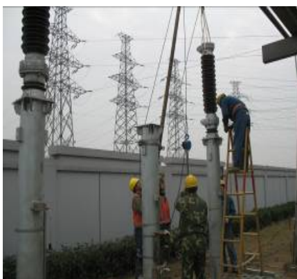
图 10 220kV 典巷变 110kV 竹舍间隔避雷器吊装现场
