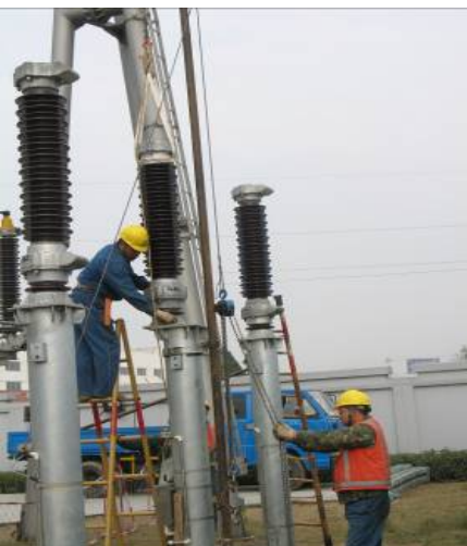
图 11 220kV 典巷变 110kV 竹舍间隔避雷器吊装现场
