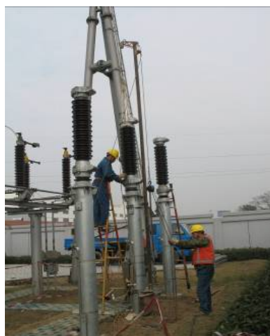
图 12 220kV 典巷变 110kV 竹舍间隔避雷器吊装现场 对相关变电所 110kV 间隔避雷器吊装情况进行了统计，如表 1 所示。
