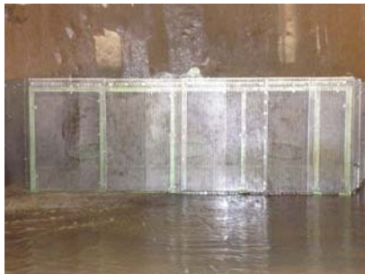
图4 滤网骨架和钢结构外表玻璃磷片防腐
