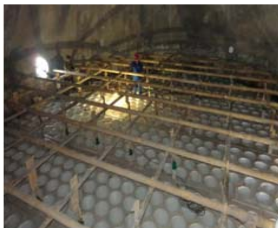
图 7 管束式除尘除雾器的现场安装实例
