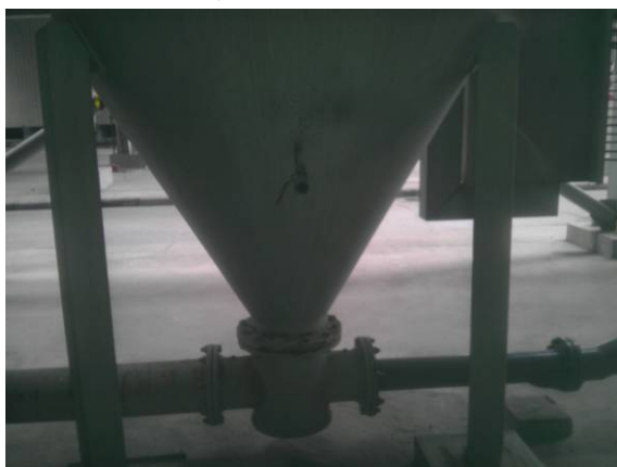
图 1 传统简单的飞灰取样装置 (正面)
