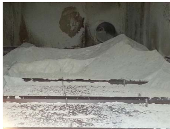
图 6 声波吹灰器出口处积灰严重
